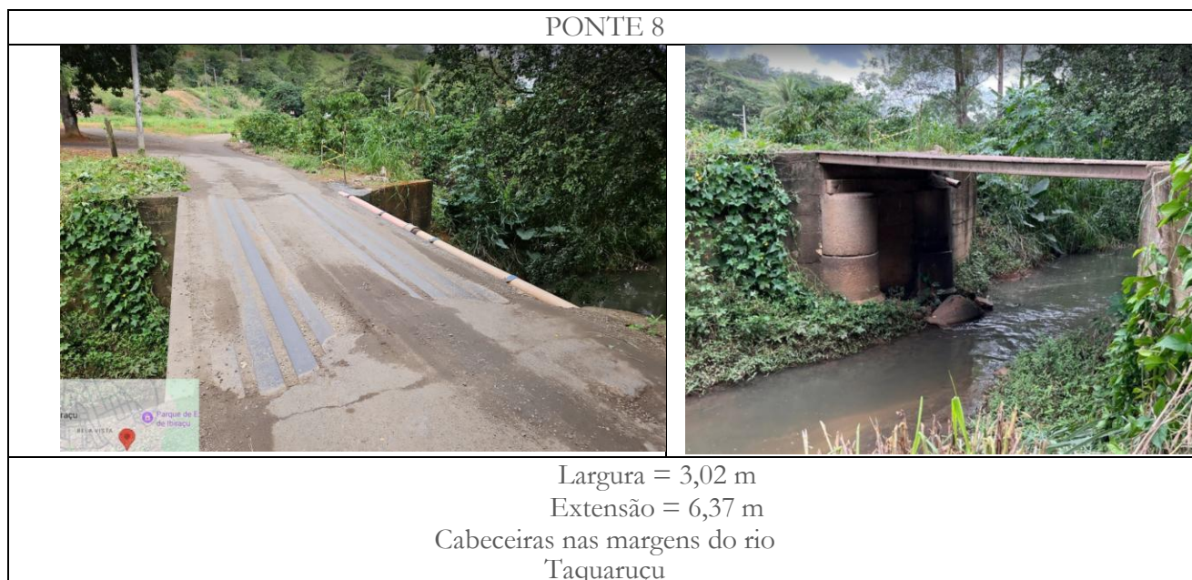
Figura 13 – Estrutura de transposição de talvegue existente ao longo do rio Taquaruçu – PONTE 8
