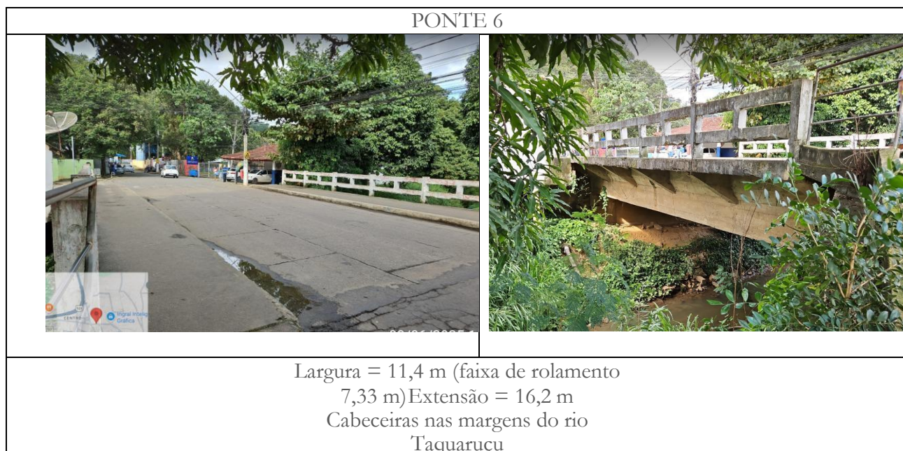
Figura 11 – Estrutura de transposição de talvegue existente ao longo do rio Taquaruçu – PONTE 6
