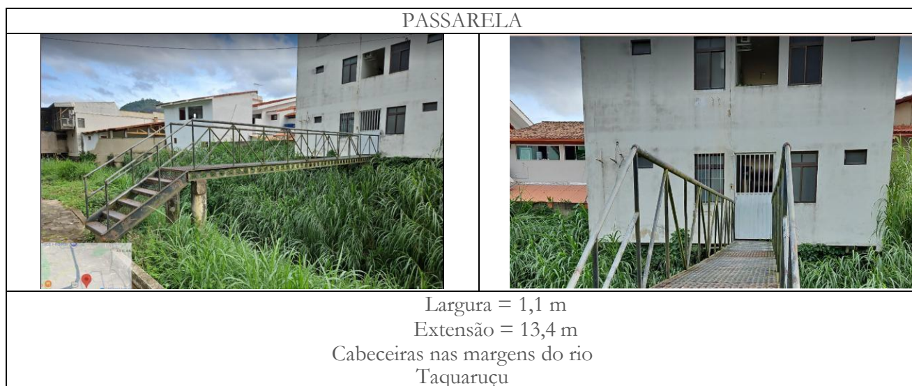
Figura 10 – Estrutura de transposição de talvegue existente ao longo do rio Taquaruçu – PASSARELA
