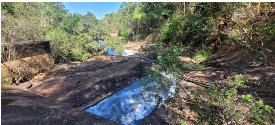
Figura 16 – Vista da seção do rio Taquaruçu imediatamente a jusante da barragem a ser retirada
