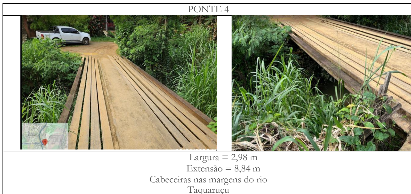
Figura 9 – Estrutura de transposição de talvegue existente ao longo do rio Taquaruçu – PONTE 4
