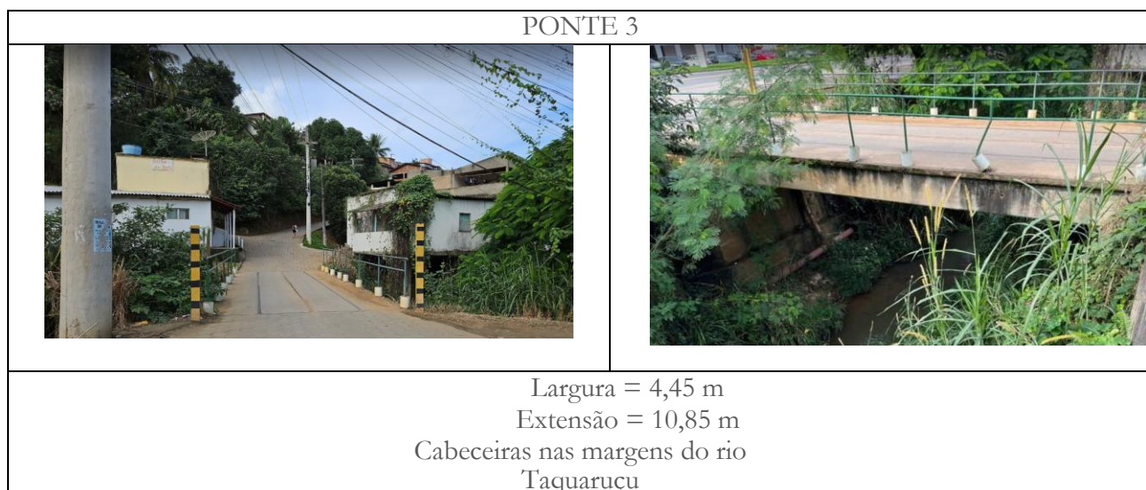
Figura 8 – Estrutura de transposição de talvegue existente ao longo do rio Taquaruçu – PONTE 3
