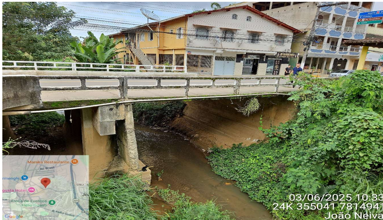
Localização da ponte 06
