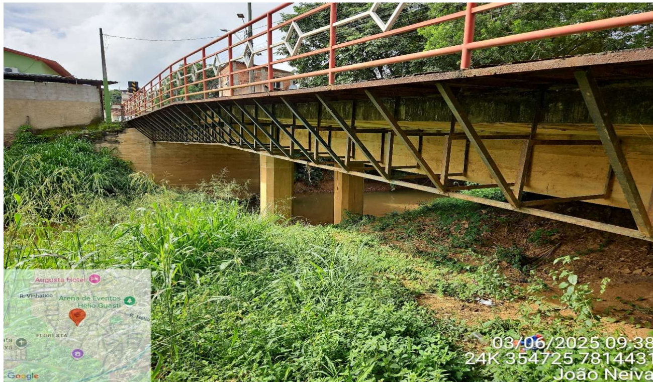
Localização da ponte 09
