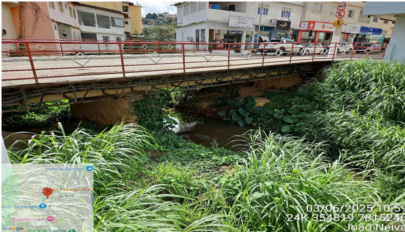
Localização da ponte 04
