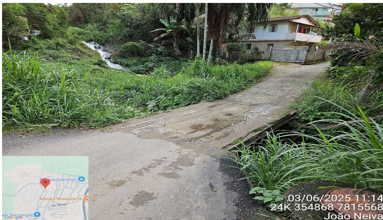
Localização da ponte 03
