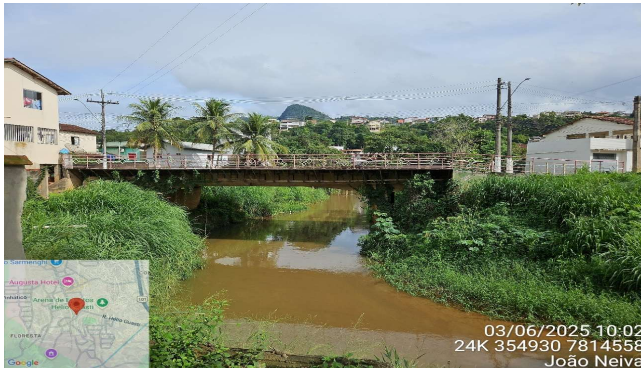
Localização da ponte 08
