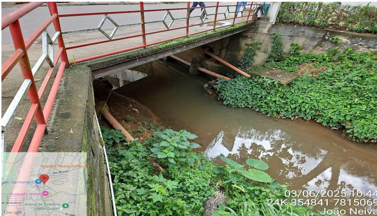
Localização da ponte 05
