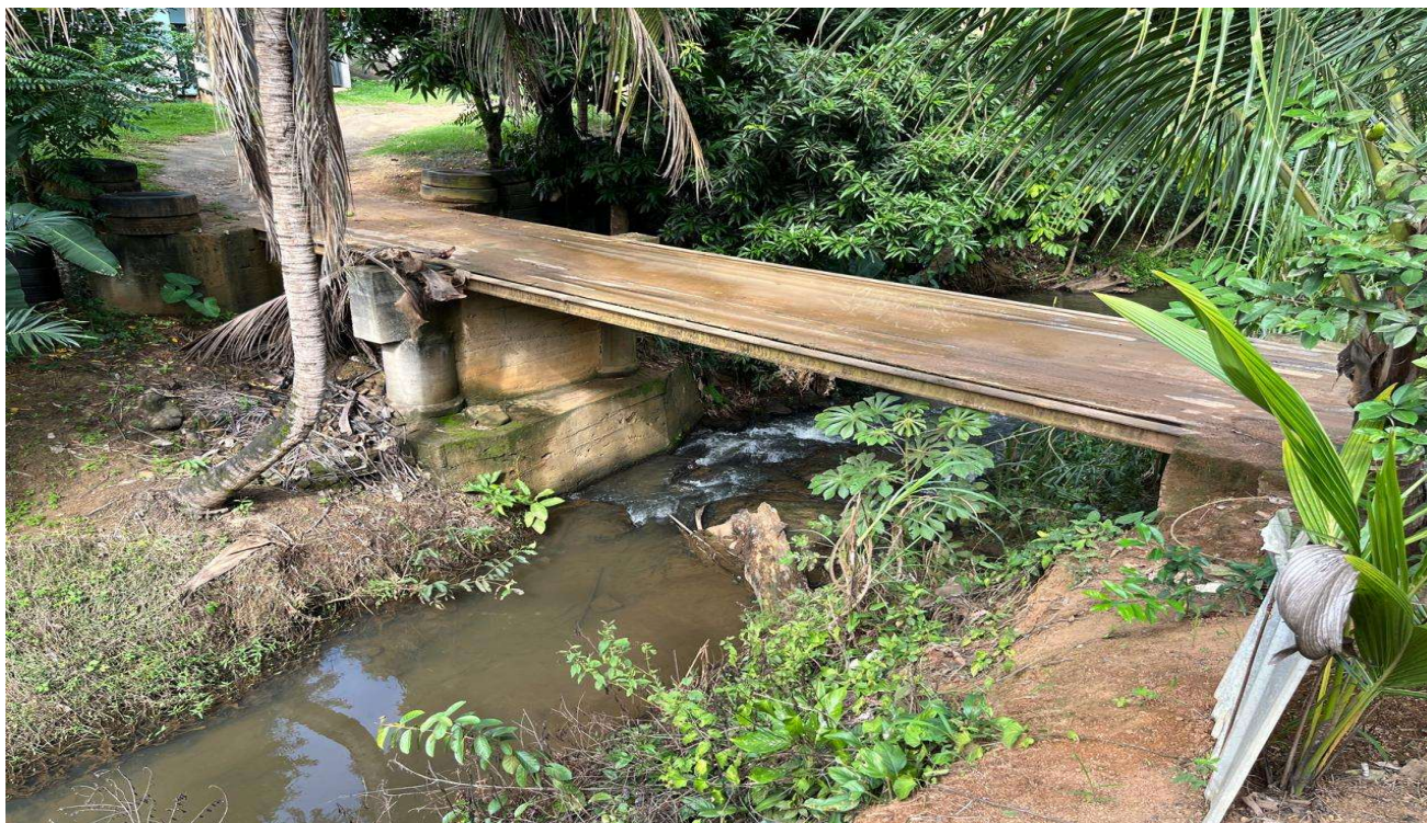
Localização da ponte 01
