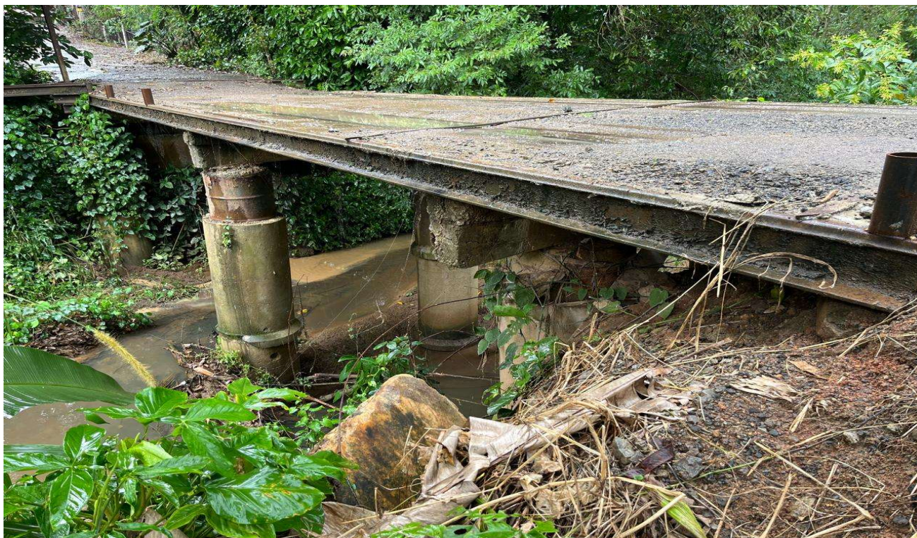
Localização da ponte 09
