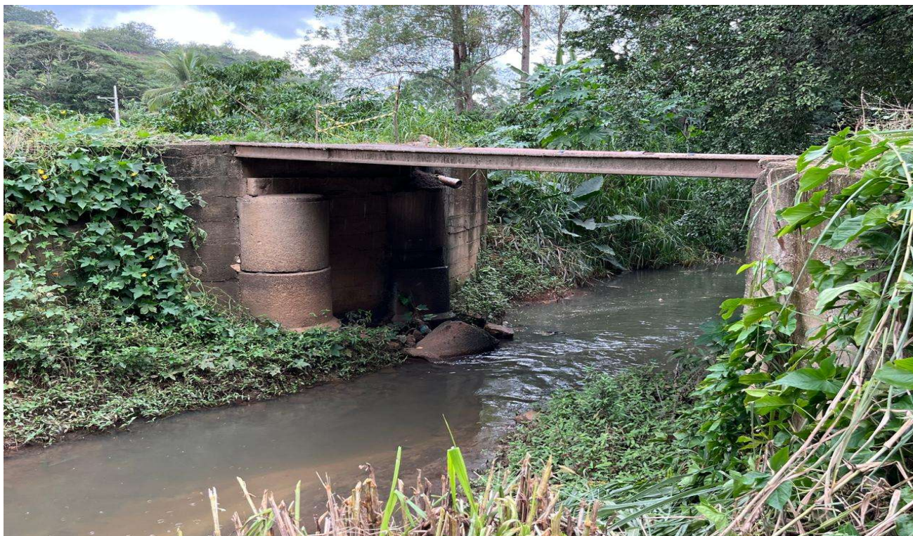
Localização da ponte 07
