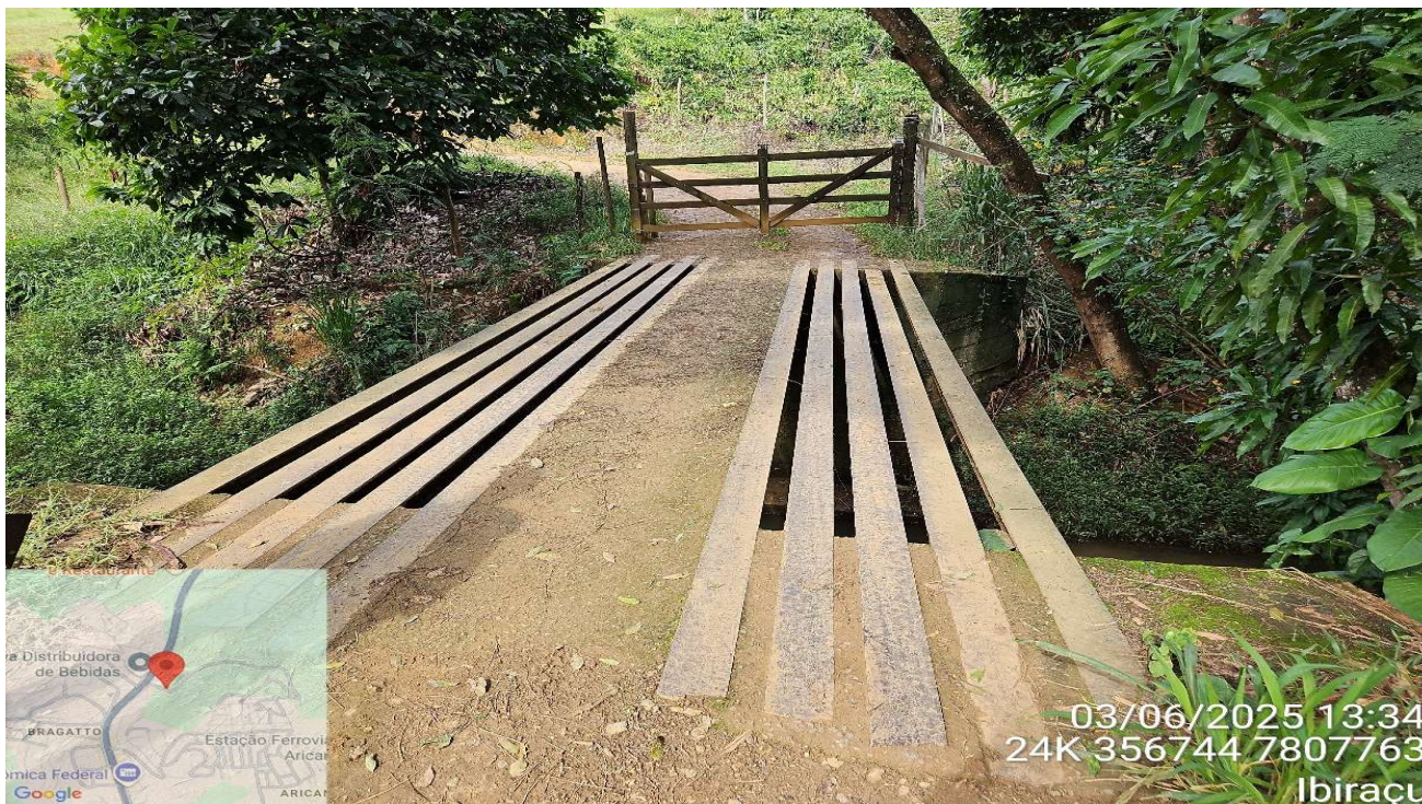
Localização da ponte 02
