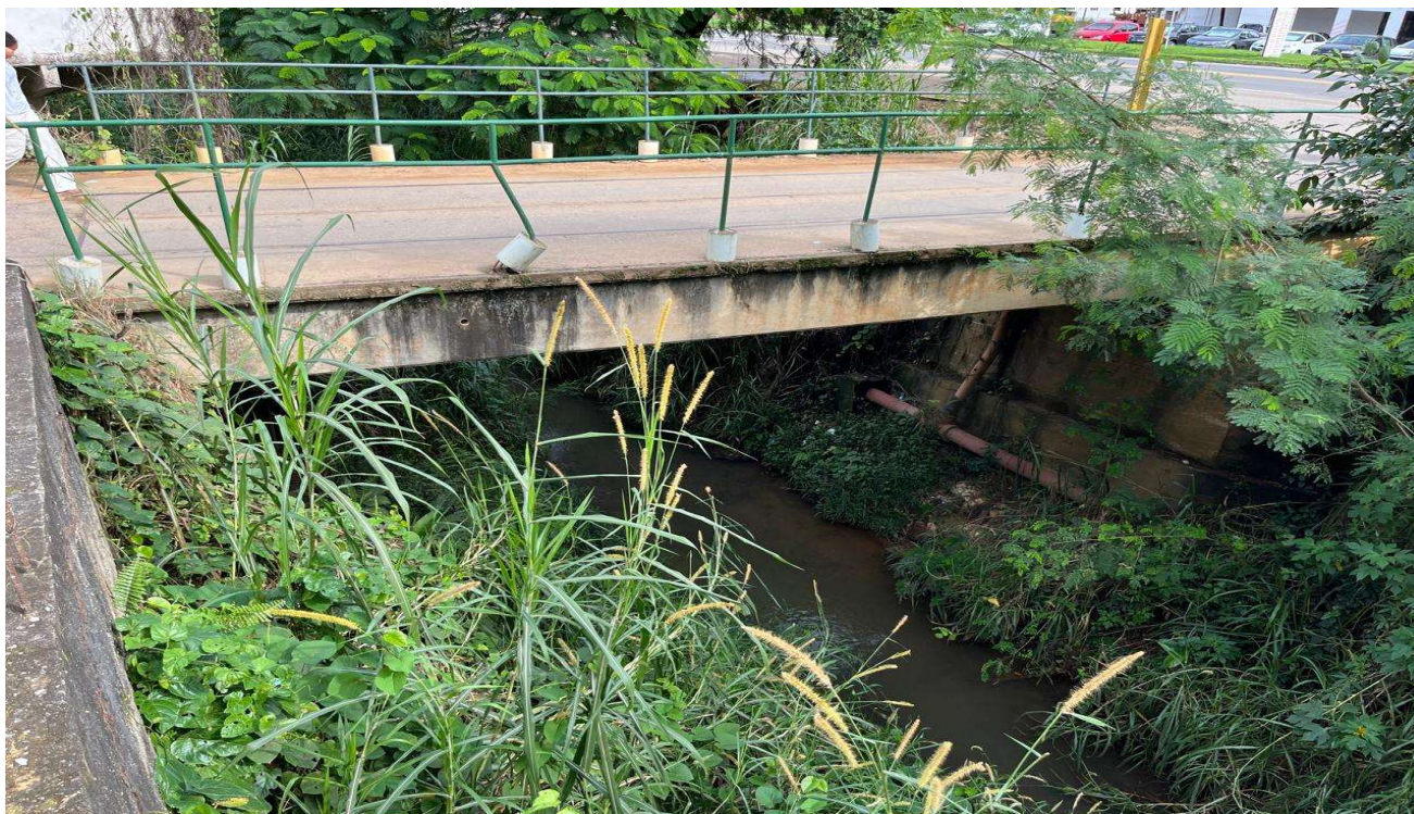
Localização da ponte 03
