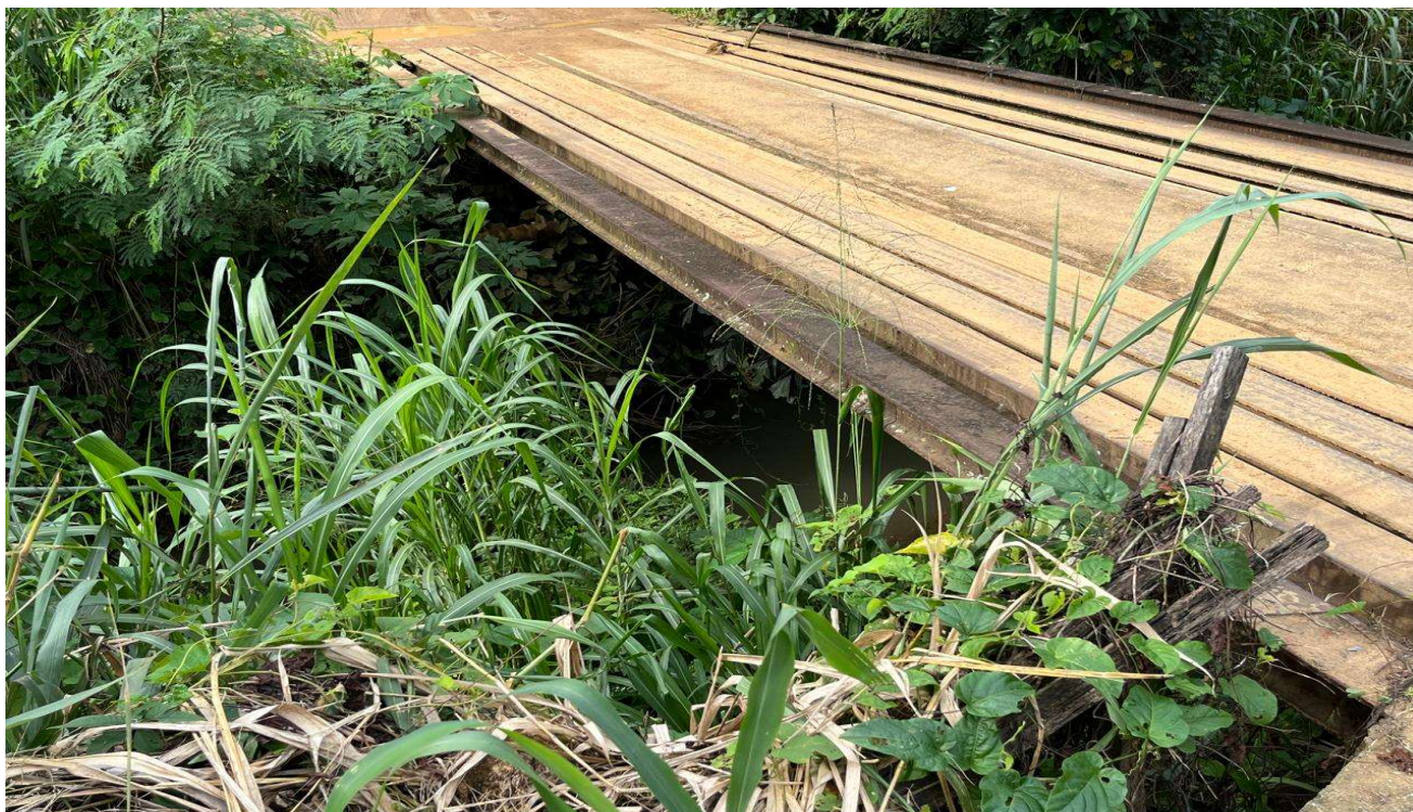
Localização da ponte 04
