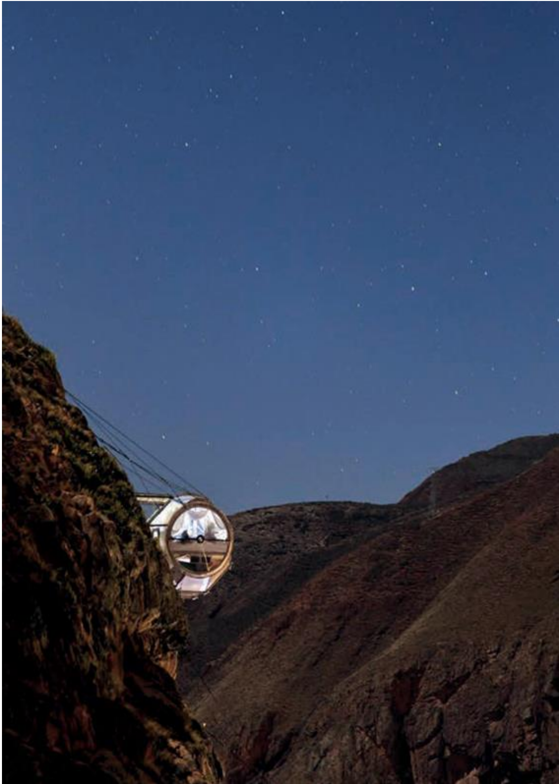
Figura 174: Zona 3 - Pedra Azul - Referência A: Skylodge Adventure Suites | Valle Sagrado, Peru | Área. 17,64 m 2
