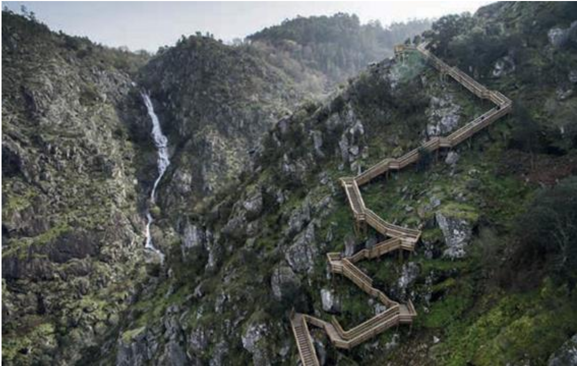
Figura 177: Zona 3 - Pedra Azul - Referência B: Passadiços do Paiva / Trimetrica | Portugal | Ano 2015
