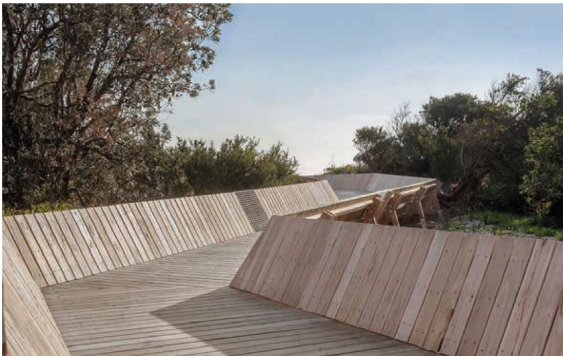
Figura 192: Zona 5 - Circuito das Trilhas - Referência C: Seaford Foreshore / SITE OFFICE | Texas, Estados Unidos | Ano 2014
