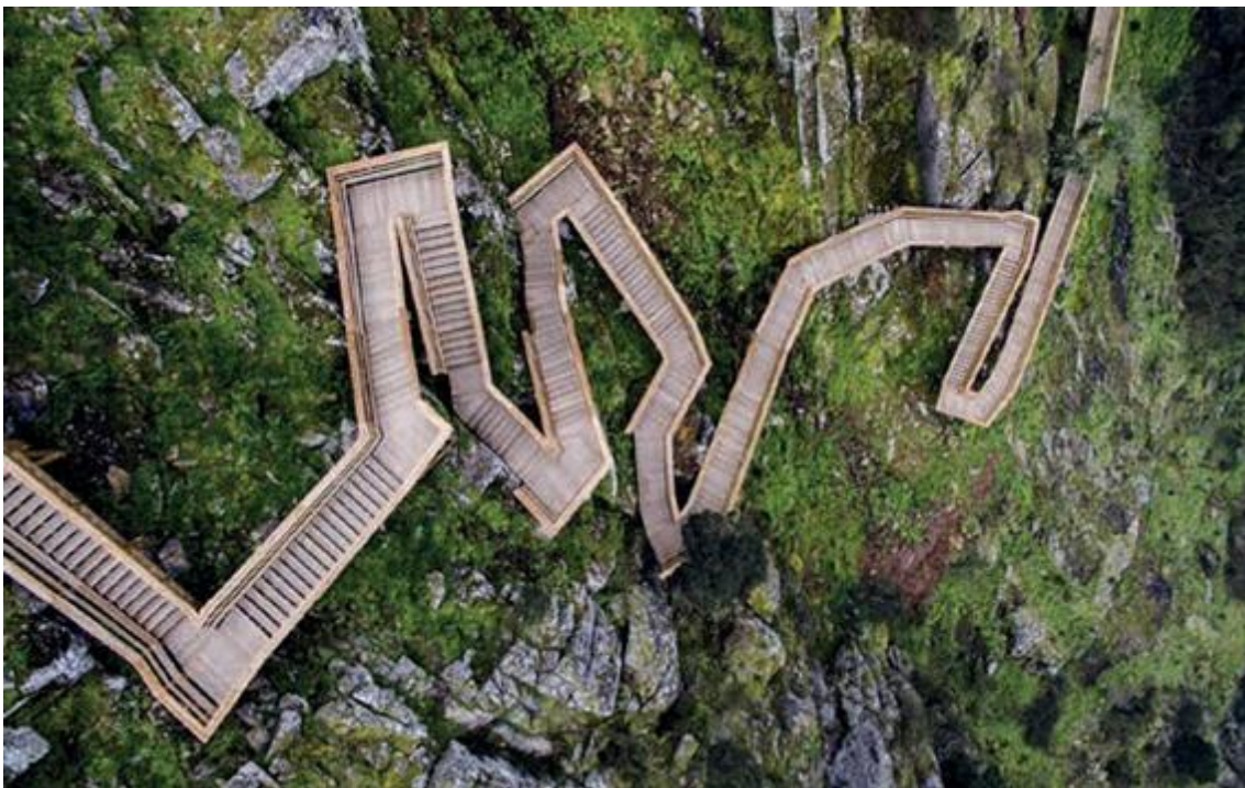
Figura 178: Zona 3 - Pedra Azul - Referência B: Passadiços do Paiva / Trimetrica | Portugal | Ano 2015
