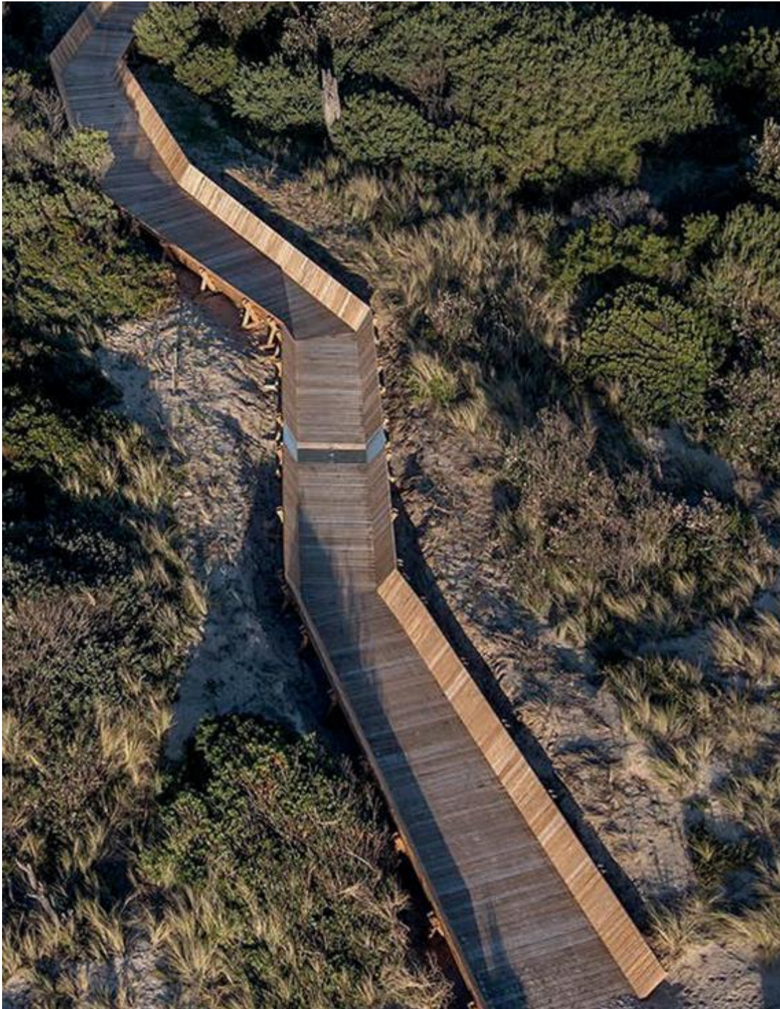
Figura 193: Zona 5 - Circuito das Trilhas - Referência C: Seaford Foreshore / SITE OFFICE | Texas, Estados Unidos | Ano 2014
