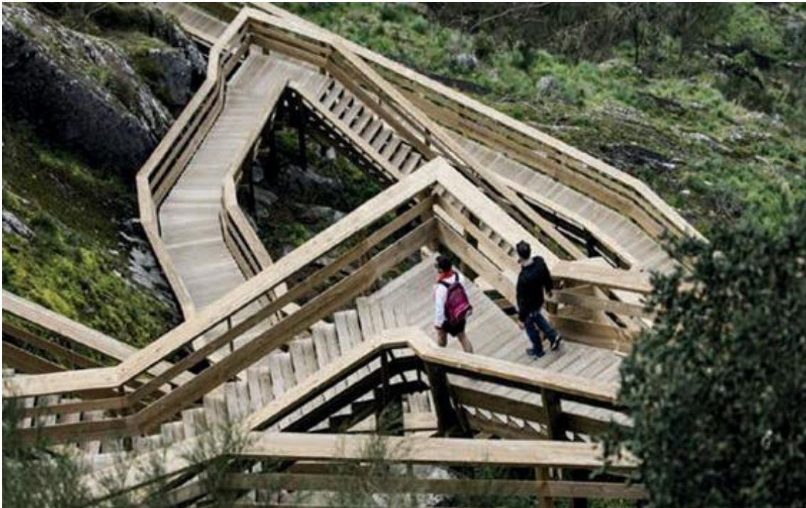
Figura 179: Zona 3 - Pedra Azul - Referência B: Passadiços do Paiva / Trimetrica | Portugal | Ano 2015
