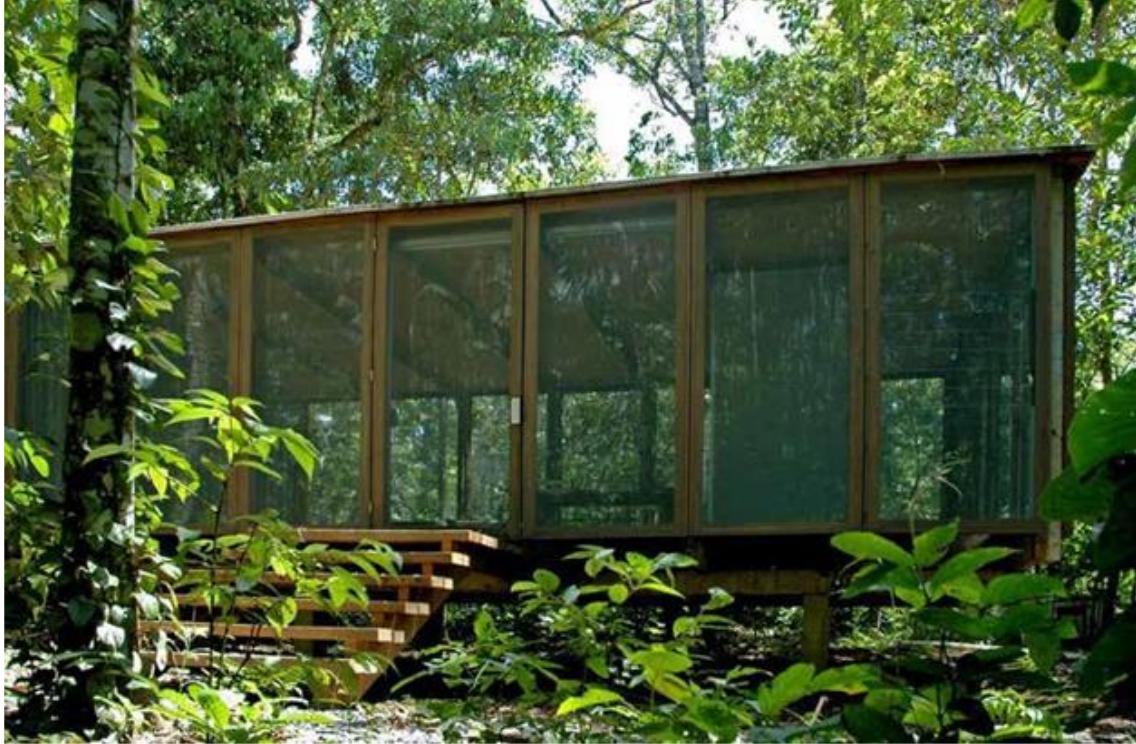
Figura 199: Zona 1 - Portaria Principal | Referência B: Casa na Mata / Nitsche Arquitetos localização | São Paulo, Brasil | Ano 2005 | Área 65 m 2
