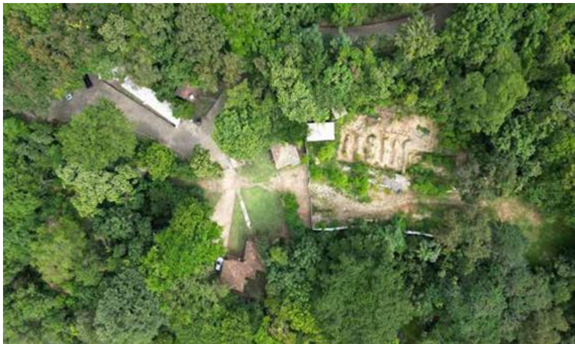
Figura 148: Sede do Parque | Administração e Centro de Visitantes (em construção)
