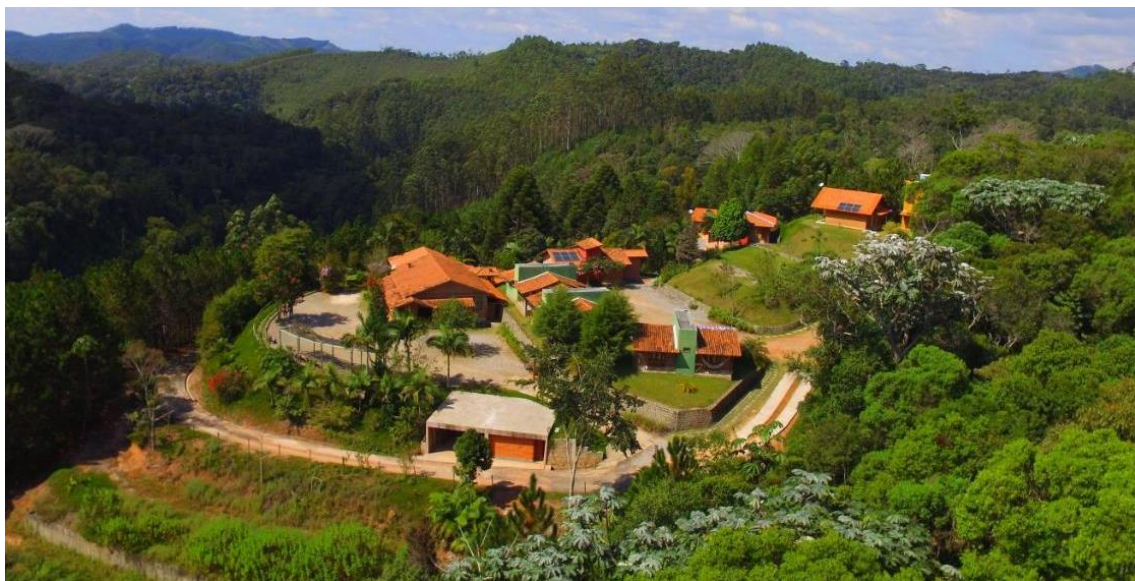
Figura 79: Pousada Vale Du'Carmo
