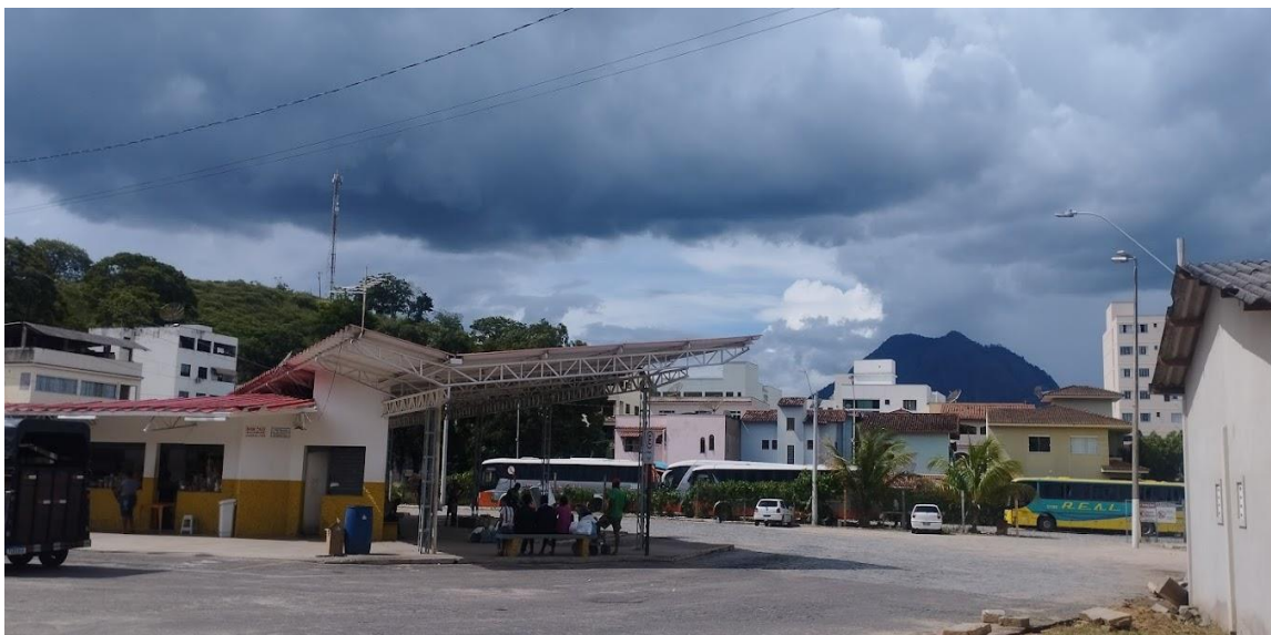
Figura 18: Rodoviária de Castelo
