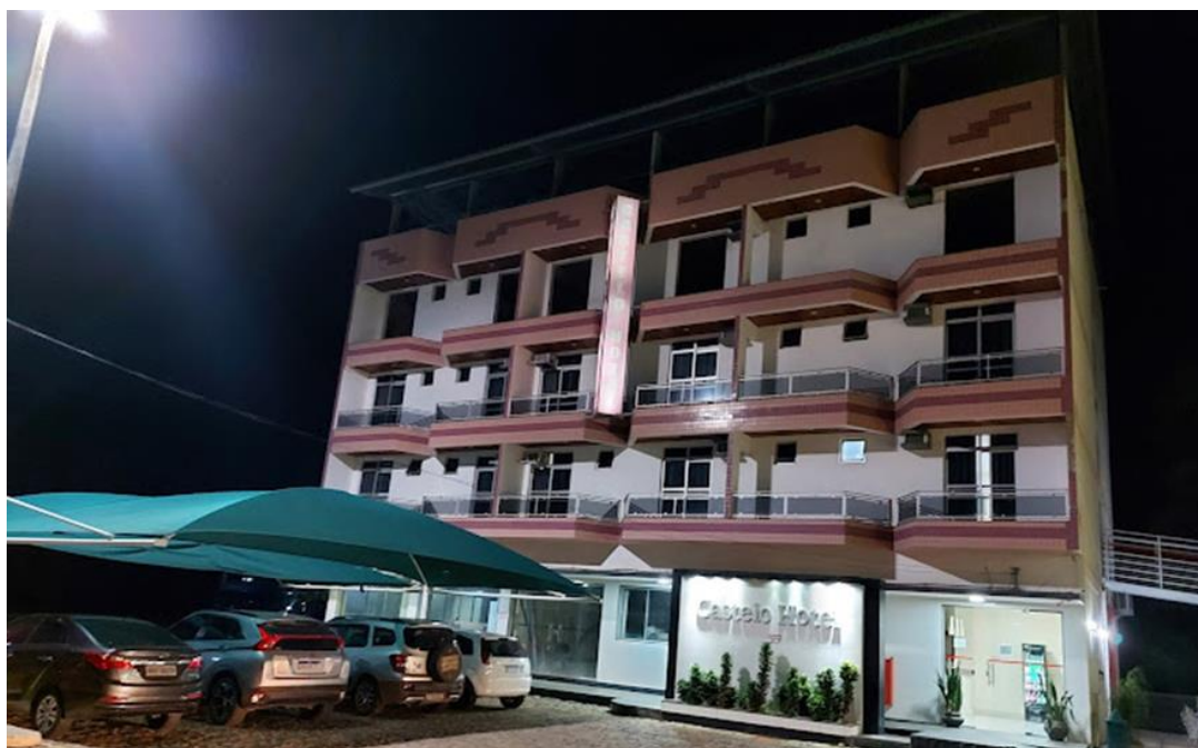
Figura 46: Entrada no Castelo Hotel
