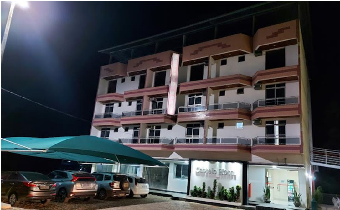
Figura 41: Entrada no Castelo Hotel
