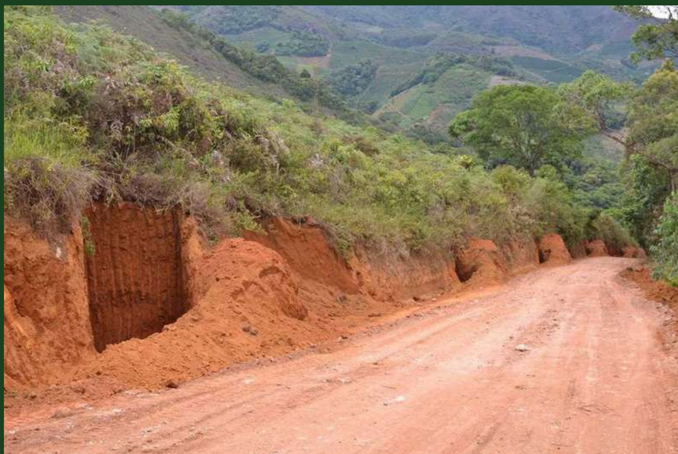
Caixas secas: Pequenas bacias retangulares de captação das águas pluviais, escavadas às margens das estradas vicinais de terras, do lado interno das mesmas.
