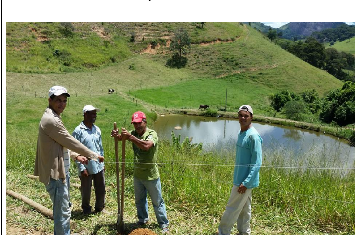
Foto 10 – Etapa de cercamento das nascentes
