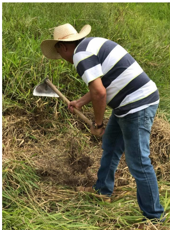
Foto 15 – Etapa de execução de coroamento
