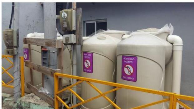
Figura 21: Sistema de aproveitamento de água de chuva instalado, com parte da comunicação visual.
