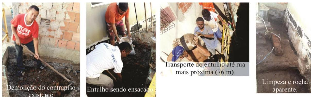
Figura 6: Demolição do contrapiso existente, remoção do entulho, limpeza até se chegar na rocha. A área de locação das caixas deve estar nivelada e com cotas precisas para o bom funcionamento do sistema. Por esta razão, optou-se por fazer furos na rocha para chumbamento de armadura e a construção de uma cinta para nivelamento conforme apresentam a Figura 7, a Figura 8 e a Figura 9.
