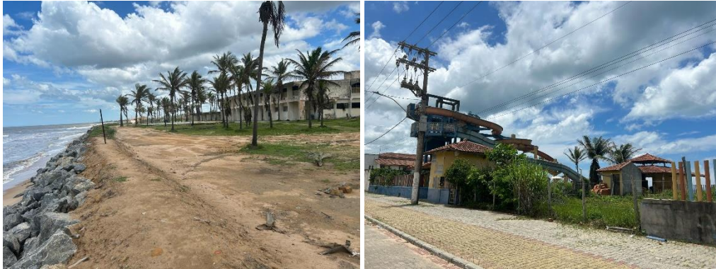
Figura 10 - Erosão da Praia e Estruturas Abandonadas (Hotel Barramar e Parque Aquático)
