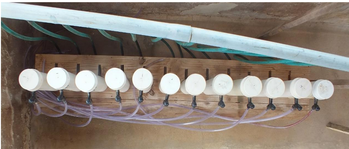
Figura 4 - Vista Superior dos Filtros anaeróbios em operação
