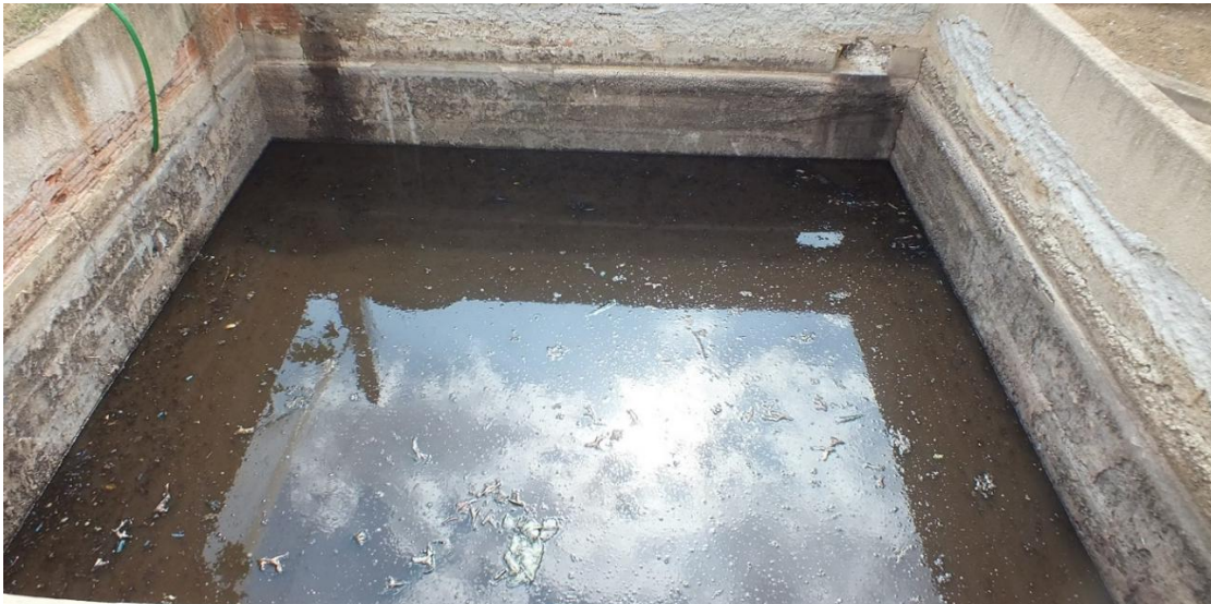
Figura 3 - Caixas de armazenamento do Efluente Bruto do Setor de Suinocultura do Ifes - campus Santa Teresa- ES
