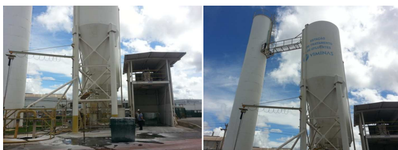
Figura 3. Água residual bombeada até o silo e filtro de decantação de resíduos, fonte: autor
