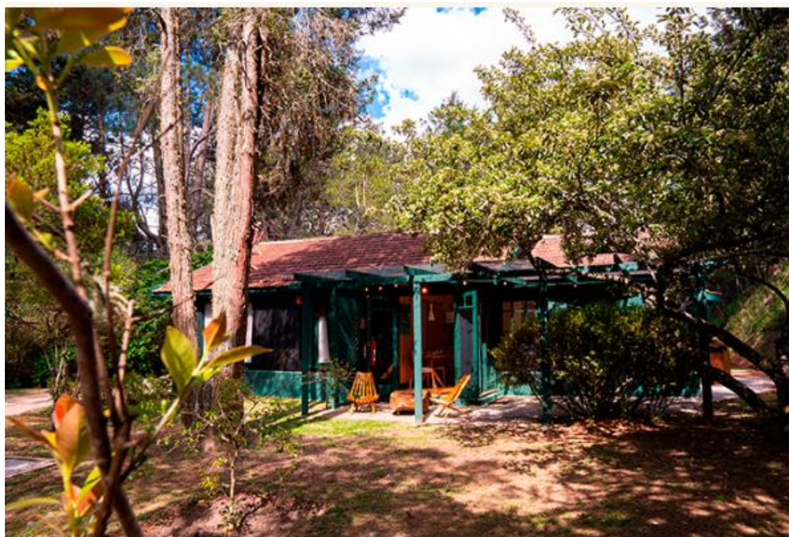
Figura 123: Casa Aventoriba Lodge
