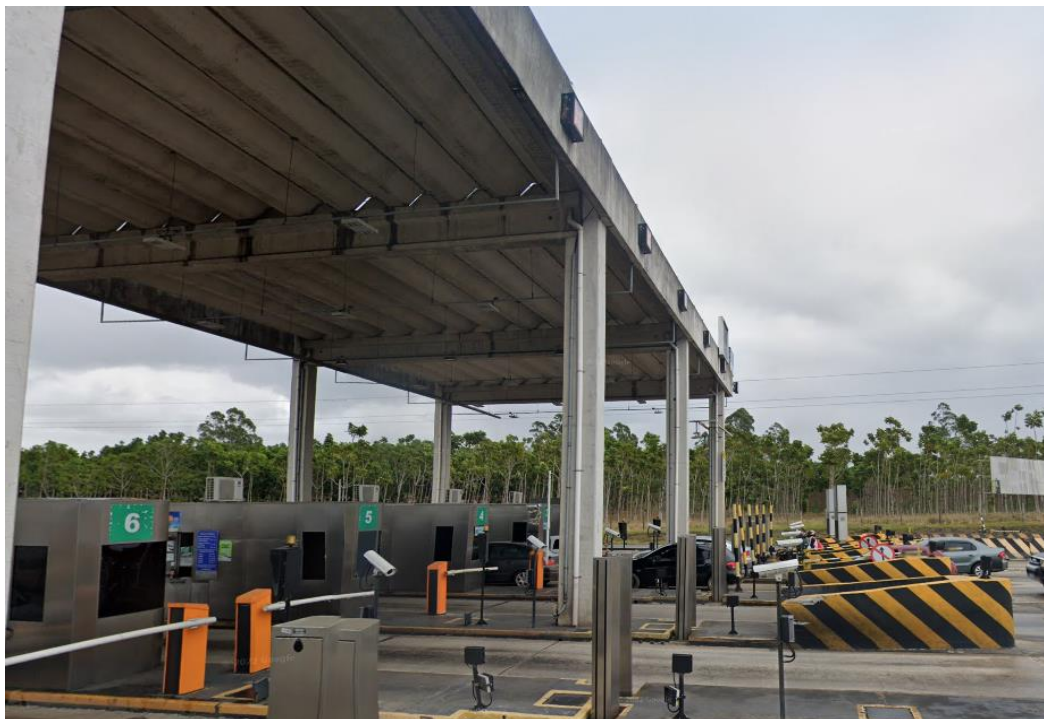
Figura 34: Posto de Pedágio Rodovia BR-101/ES, Km. 86 - Eco101
