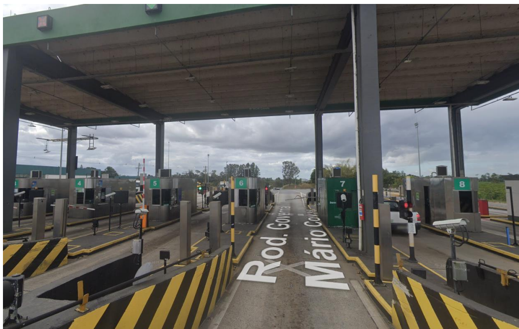
Figura 33: Posto de Pedágio Rodovia BR-101/ES, Km. 172 - Eco101
