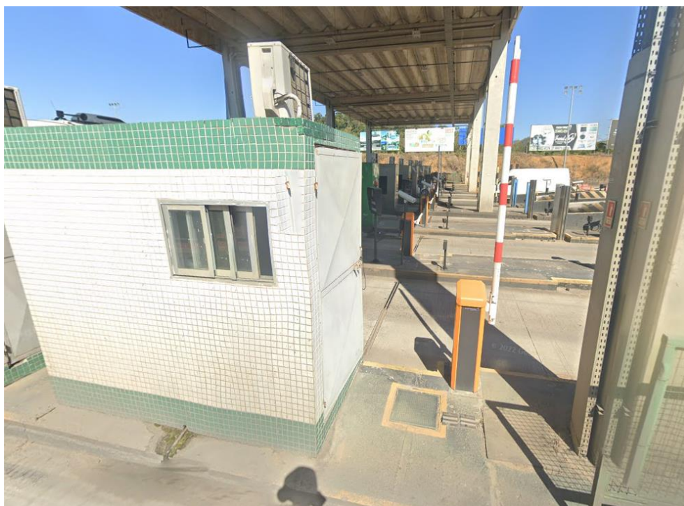
Figura 32: Posto de Pedágio Rodovia BR-101/ES, Km. 242 - Eco101
